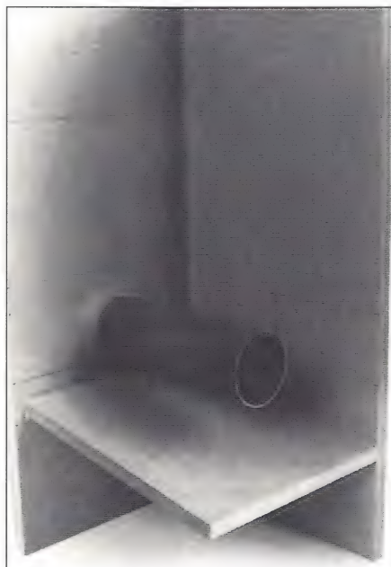
de reflexpijp met daaronder de schuin ingezette bodemplaat
